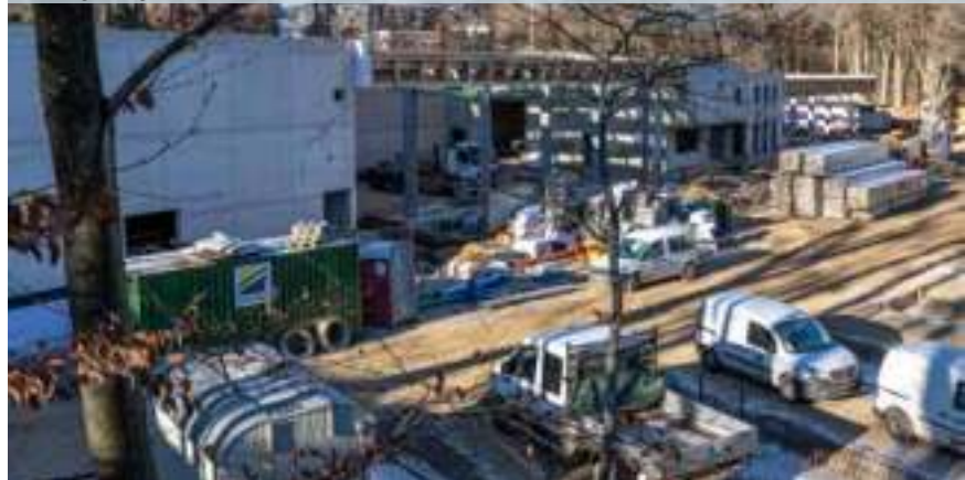
Hier entsteht das neue Gebäude unseres Straßendienstes sowie ein neuer Trinkwasserbehälter in Senningerberg.
